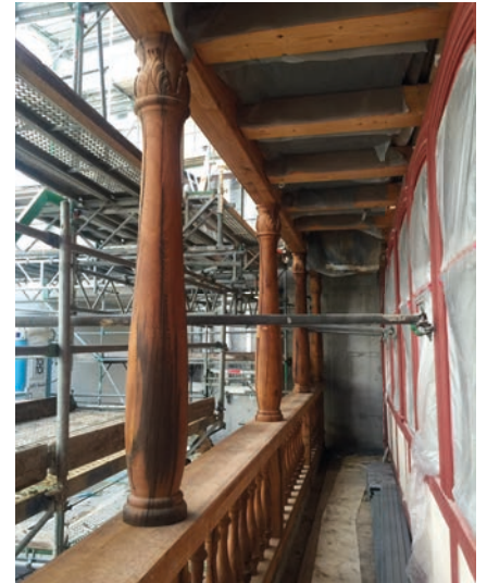
Beeindruckend die doppelstöckige Holzgalerie am „Haus Rebstock“, für deren Rekonstruktion 300 – 400 Jahre altes Eichenholz eingesetzt wurde. Die Stützen sind gedrechselt und das Relief im oberen Abschluss ist jeweils handgeschnitzt.
